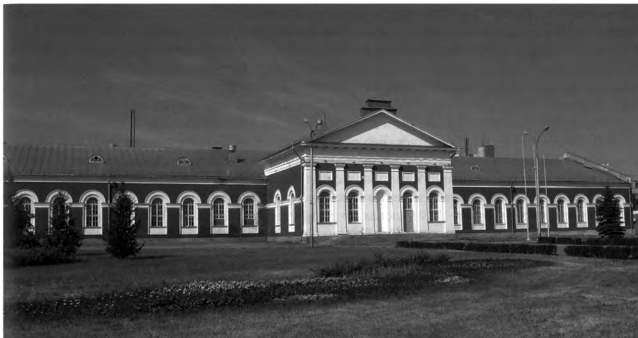
Рис. 4. Манеж и здание церкви св. Александра Невского. Фотография 2007 г.
