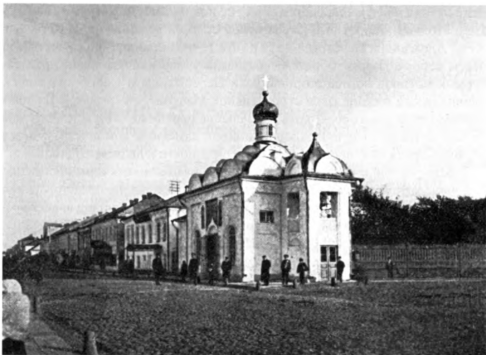
Ил. 115. Церковь Александра Невского. Вид с северо-запада. Из книги В. Пылаева 1916 г.
